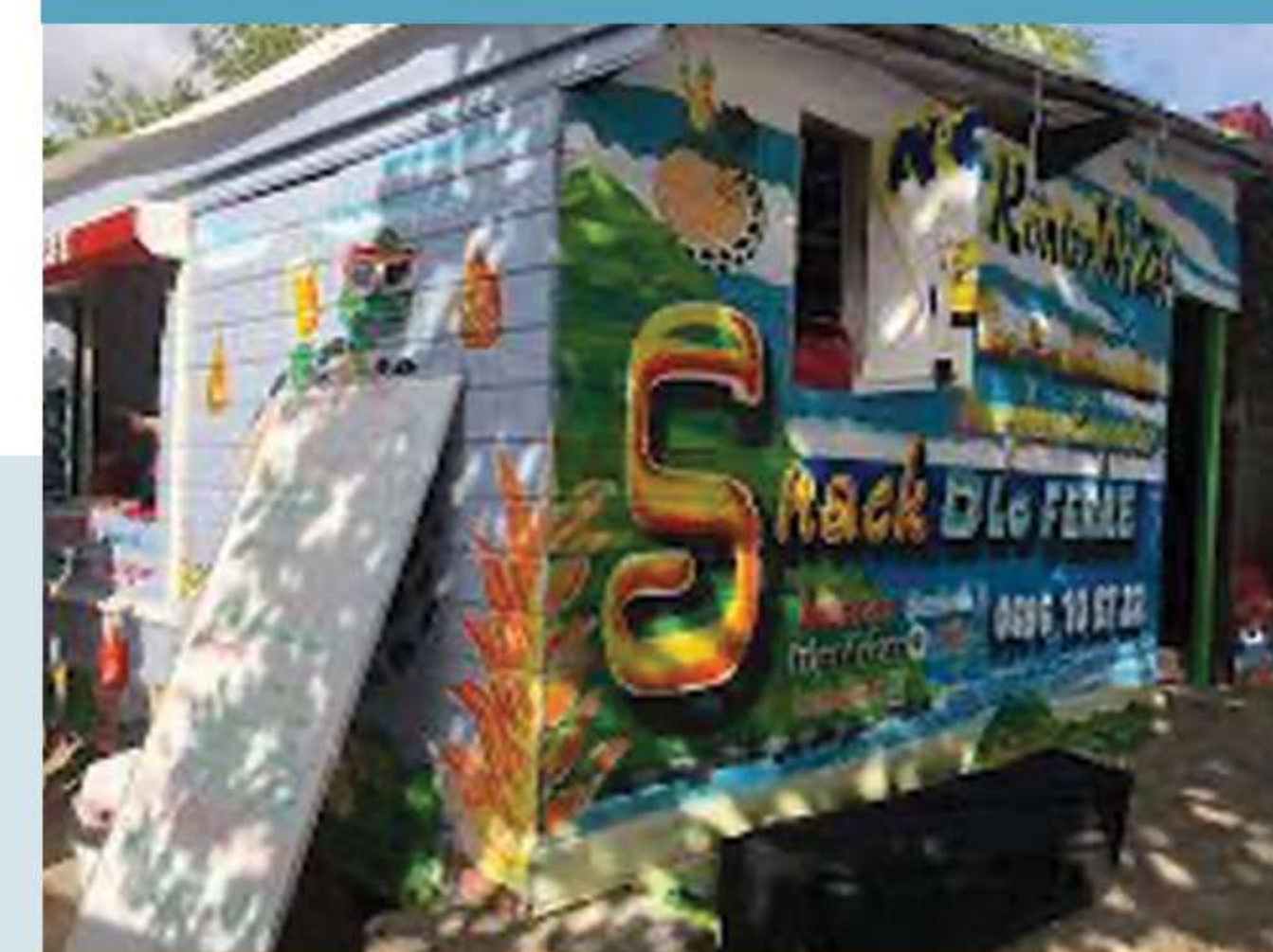
*Réhabilitation des snacks du Coin des Pères
